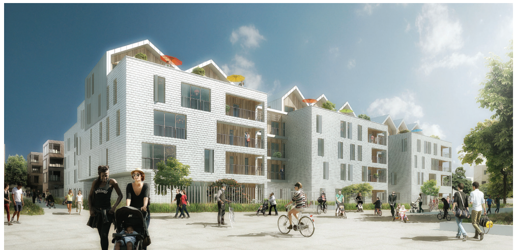
64 logements sur le cœur Pasteur (lot P5) et 11 logements sur l'îlot Briais (lot B7), ARCHI 5/REI.
